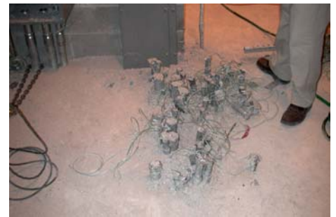
Security system conduit before -----and after slab pour
